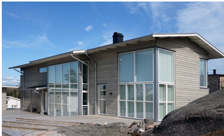
Framsida: Vattnets Hus i Ängelholm. Behandlat med SiOO:X Träskyddande Panelfärger, ljusgrå. (2017). Foto: Felix Gerlach. Ovan högst upp, hus i Älvsjö, Stockholm, SiOO:X Träskyddande Panelfärger, ljusgrå (2017). Hus i Grebbestad, behandlat med SiOO:X Träskyddande Panelfärger, mellangrå (2017).
